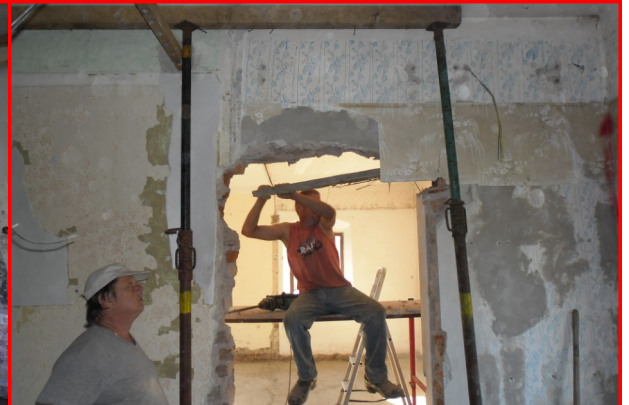
Die gefährlichsten Arbeiten im Sommer 2012
